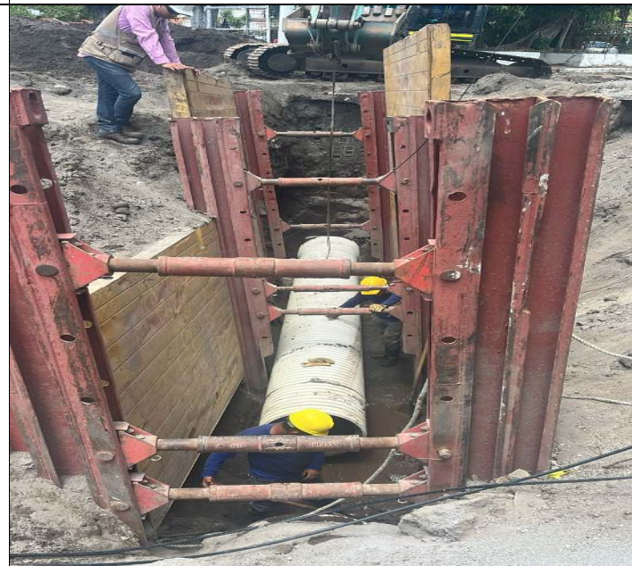
DESPUES: Calle 31 entre carrera 12 y 14 – Barrio Obrero
