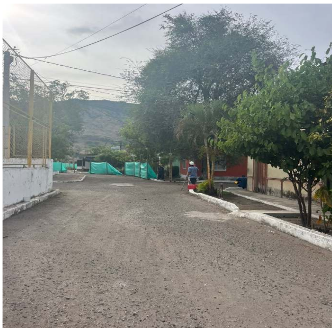
ANTES: Calle 31 entre carrera 12 y 14 – Barrio Obrero
