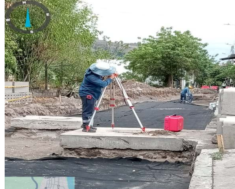
DESPUES: Carrera 15 entre calle 23 y 27 Barrio Nueva Ambalemita
